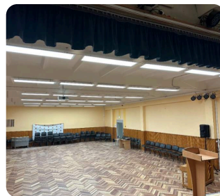
Kėdainių „Ryto“ progimnazija Aktų salės apšvietimas
